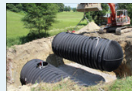
100 EW, Ettringen (Deutschland)
