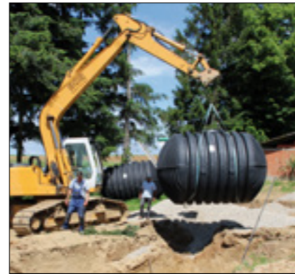
30 EW, Oberderdingen (Deutschland)
